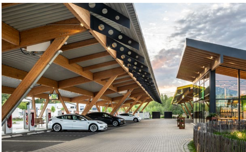
Auf dem Dach eine Solaranlage, darunter können 107 Autos laden, mit bis zu 400 kW Leistung.
